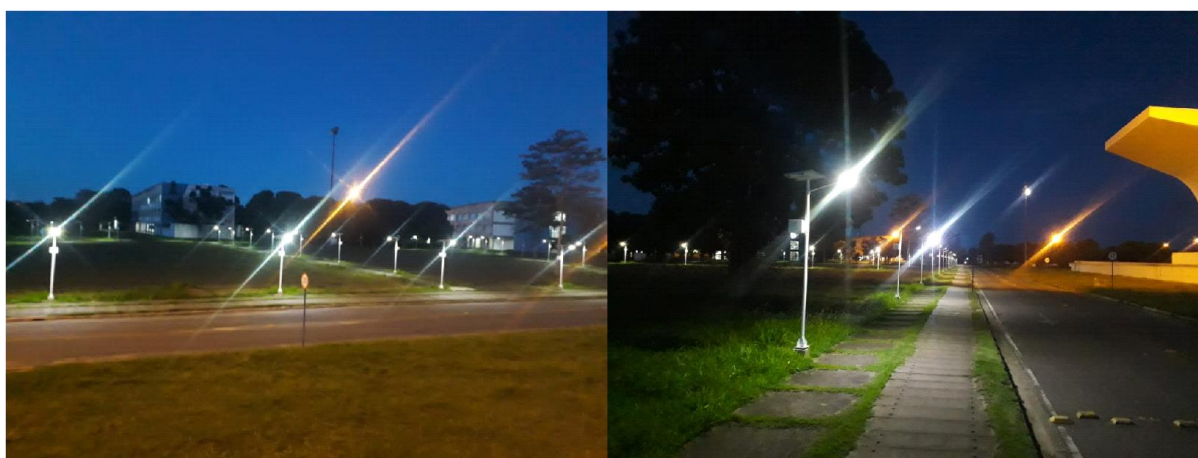
Figura 6 – Imagens mostrando a iluminação com postes de energia fotovoltaica no Campus Leonel Brizola da UENF em Campos dos Goytacazes, RJ
